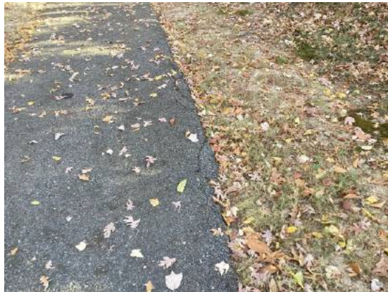
Walking path edge cracks
